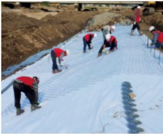
1. 지반정리 및 밑철망 설치
